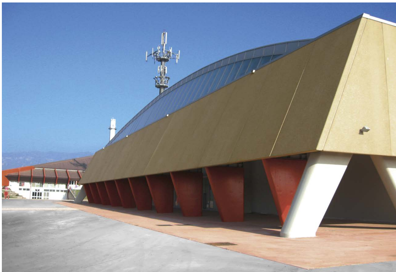
Palazzetto dello Sport _ Bassano del Grappa - VI _ Arch. Valentino Sebellin
