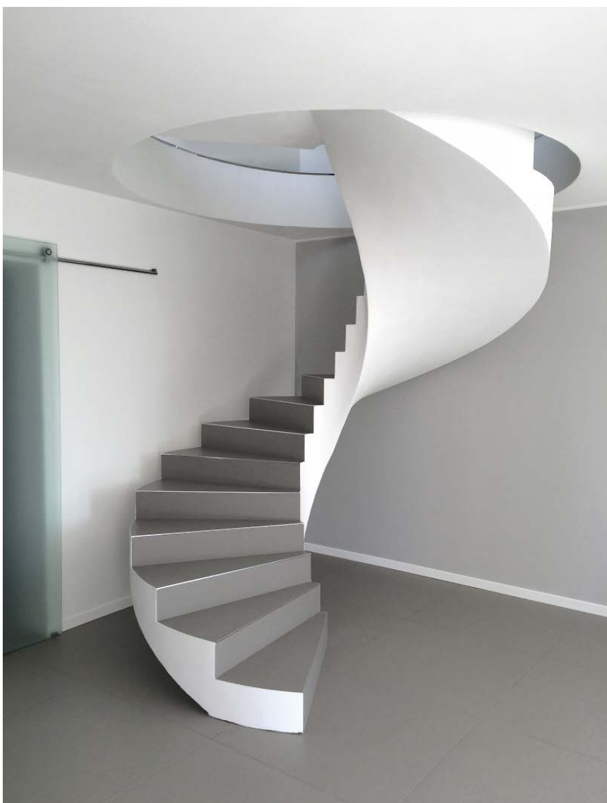
Scala a chiocciola con rivestimento in resina.
