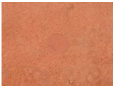
Foro Boccola chiuso con pasta cementizia.
