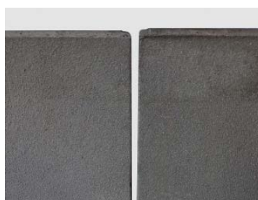
Accostamento pannelli con fuga mm 10. POSA CORRETTA. È lo spazio necessario per le dilatazioni termiche e la sigillatura.
